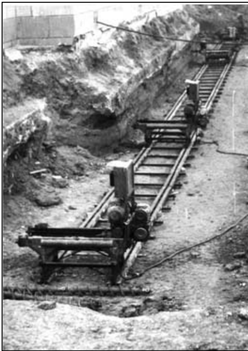
Рис. 1. Відкриті стрічкові фундаменти у процесі вирівнювання нахиленого будинку
